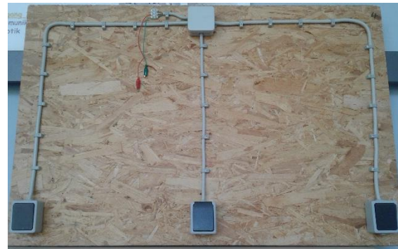
Wechselschaltung mit original Material
